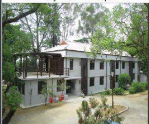
南投 中科管理局中興新村松園宿舍 Nantou Zhongxingxin Dormitory
