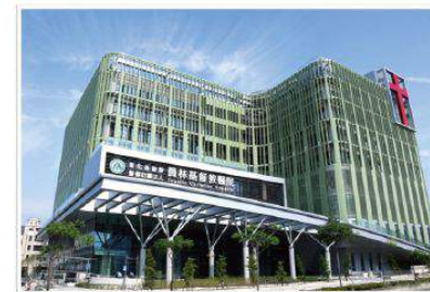
彰化基督教醫院 員林分院,榮獲LEED綠建築認證
