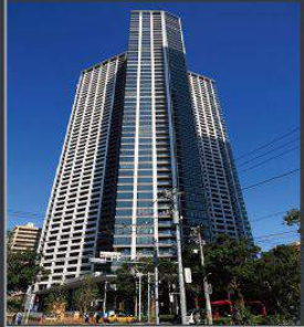
勝どきザ・タワー (KACHIDOKI THE TOWER)
